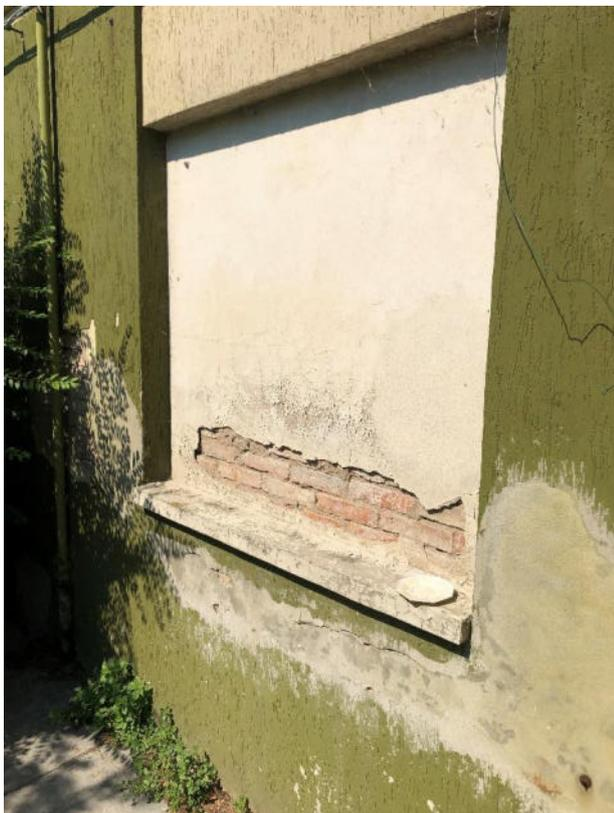
Saggio effettuato su muro perimetrale esterno in corrispondenza della finestra tamponata a piano terra
