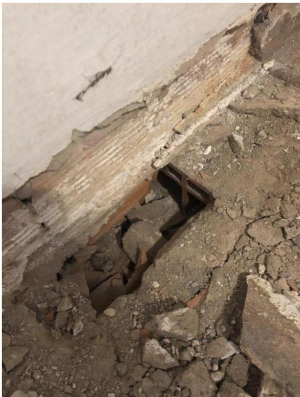
Saggio effettuato a piano primo in corrispondenza dell'incrocio tra muro portante esterno e solaio del primo impalcato
