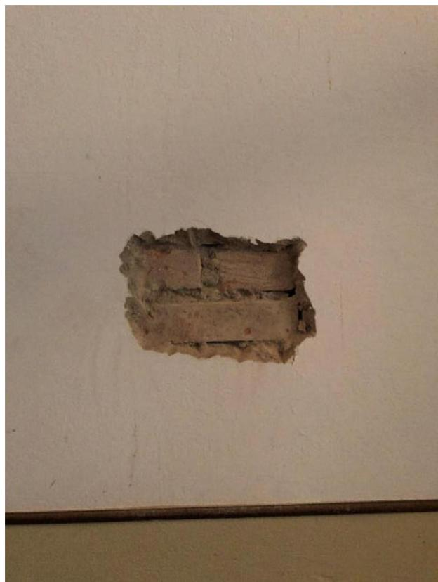
Saggio effettuato nel vano scala a piano terra, su muro portante che divide gli ambienti
