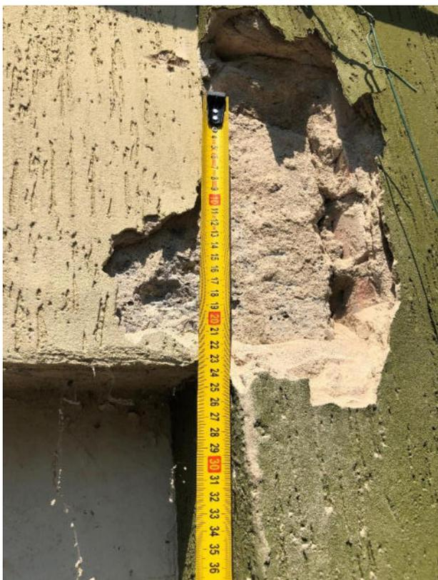
Saggio effettuato sopra alla finestra tamponata al piano terra per verificare dimensioni architrave
